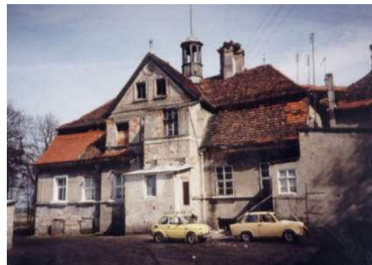
Rys.12 Pałac w Kamionej – stan obecny
