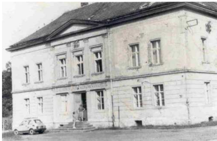
Rys. 9 Pałac w Dankowicach, zdjęcie z lat 70-tych
