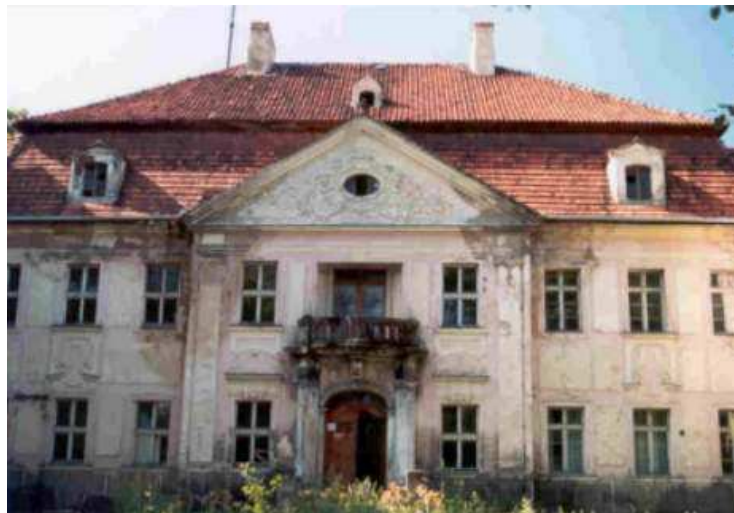
Rys. 14 Pałac w Żukowicach
